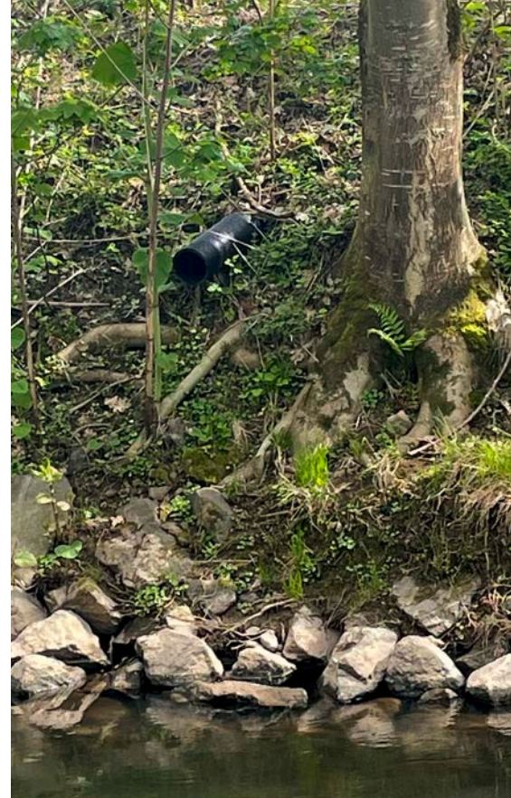
Ein Rohr gegen die Natur: Tausende solcher Einleitungen entwässern Wiesen und Felder – und machen aus Bächen Abflusskanäle.
