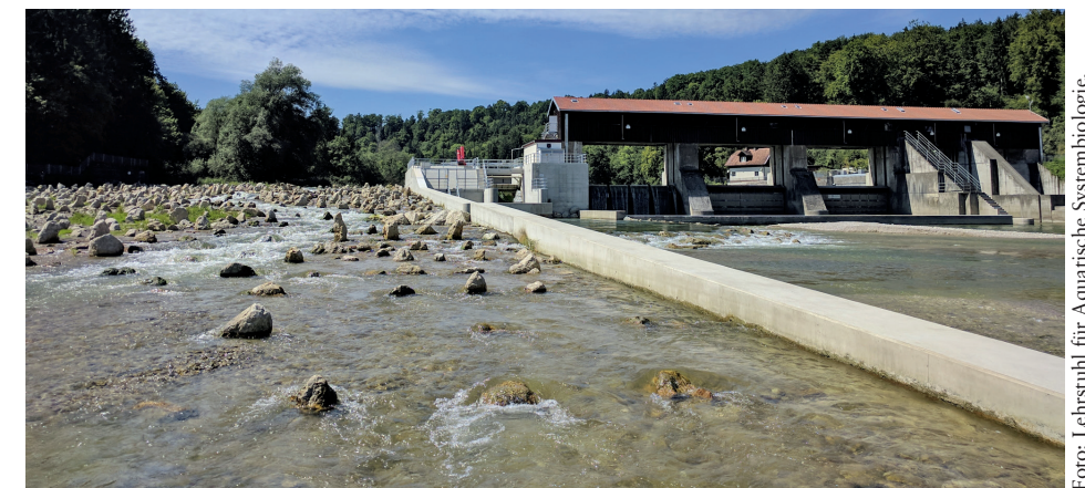
Die Fischpassage am Kraftwerk Balerbrunn (Isar) wird von 70 % der abwandernden Fische angenommen. Was nicht unbedingt berauschend klingt, ist das einzige Positivbeispiel einer umfangreichen Untersuchung.
